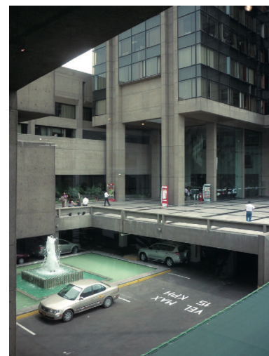
Sede de PETROPERÚ (Arqs. W. Weberhofer y D. Arana, 1969-1974).
